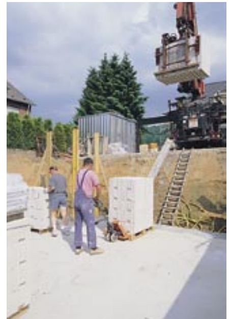
Anliefern der KS-Steine
