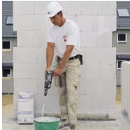
Anmischen des Dünnbettmörtels
