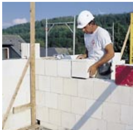
Versetzen der Steine
