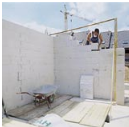
Arbeiten mit Hilfe einer Mauerlehre
