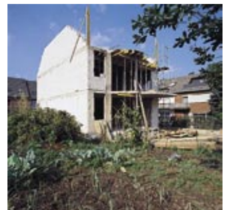
Der fertige Rohbau
