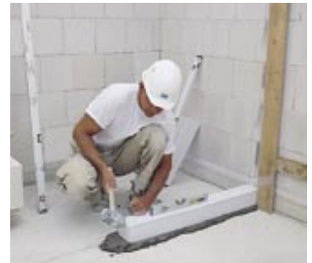
... zum Ausgleich von Unebenheiten der Bodenplatte
