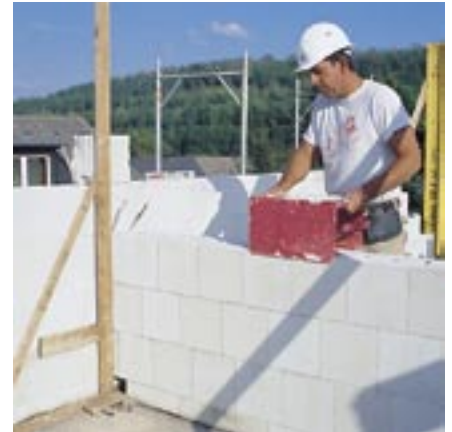
Aufziehen des Dünnbettmörtels mit dem Mörtelschlitten
